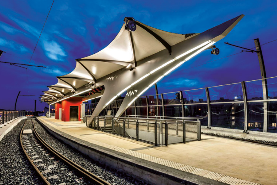
Sardinie, Cagliari – nadzemní stanice metra s navazujícím viaduktem
