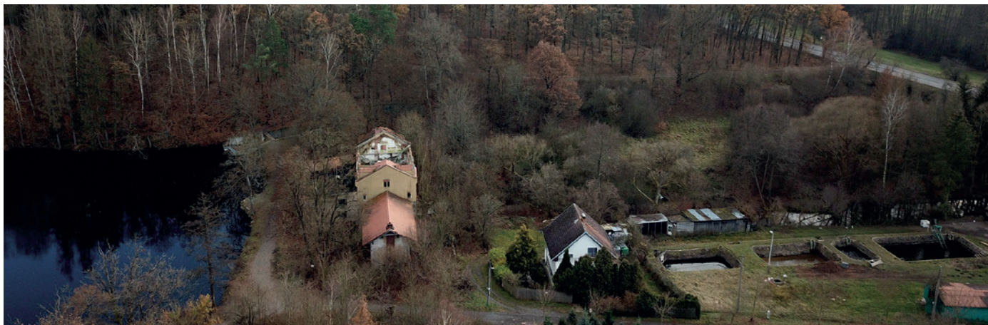
Sádky v Olešovicích. V levé části snímku pohled na propadlou střechu bývalé pekárny.
